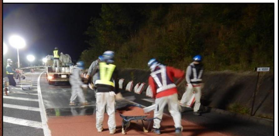
すべり止め材料の施工
